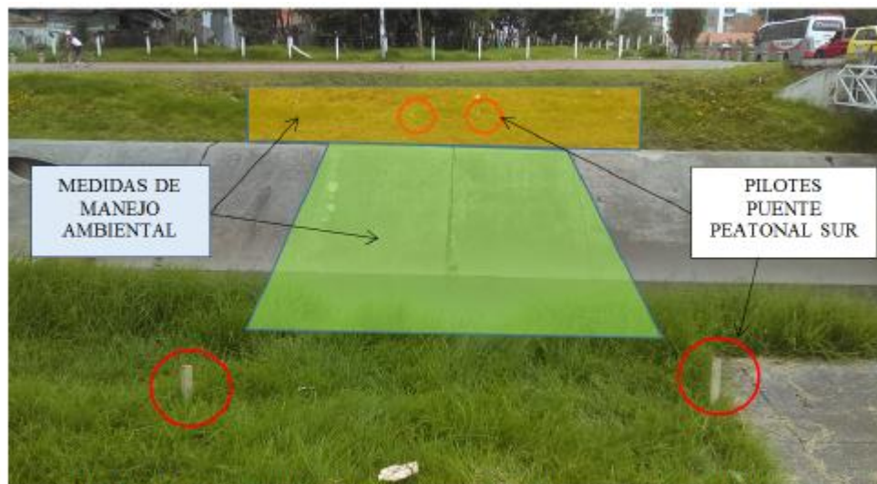
Fotografía No. 4. Zona de ubicación de las medidas de manejo ambiental a implementar para la construcción de puente peatonal (sur) sobre el canal Torca.
