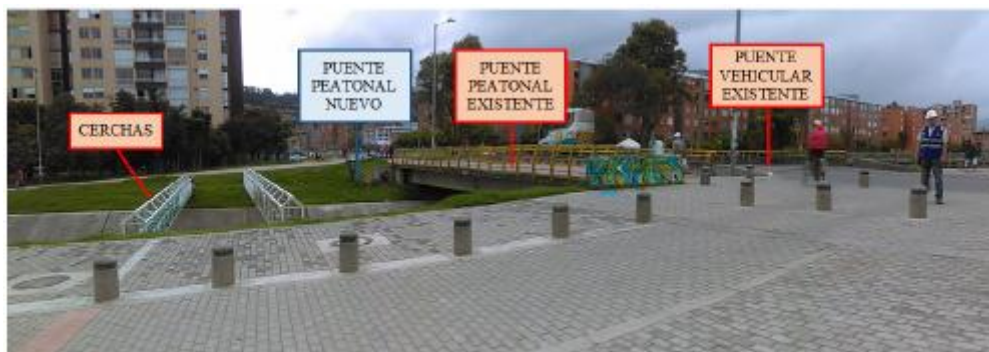
Fotografía No. 1. Zona de intervención en el Canal Torca a la altura de la Avenida Calle 183 – Costado norte.
