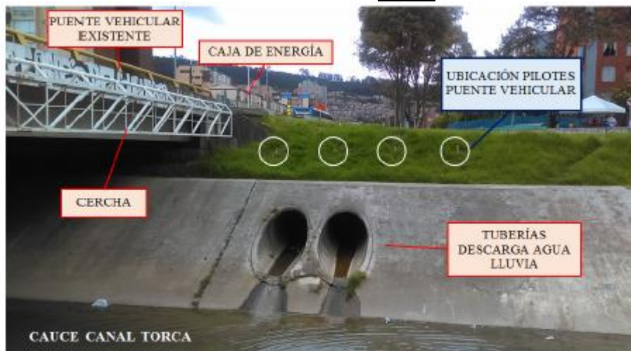
Fotografía No. 2. Zona de intervención en el Canal Torca a la altura de la Avenida Calle 183 – Costado Sur.
