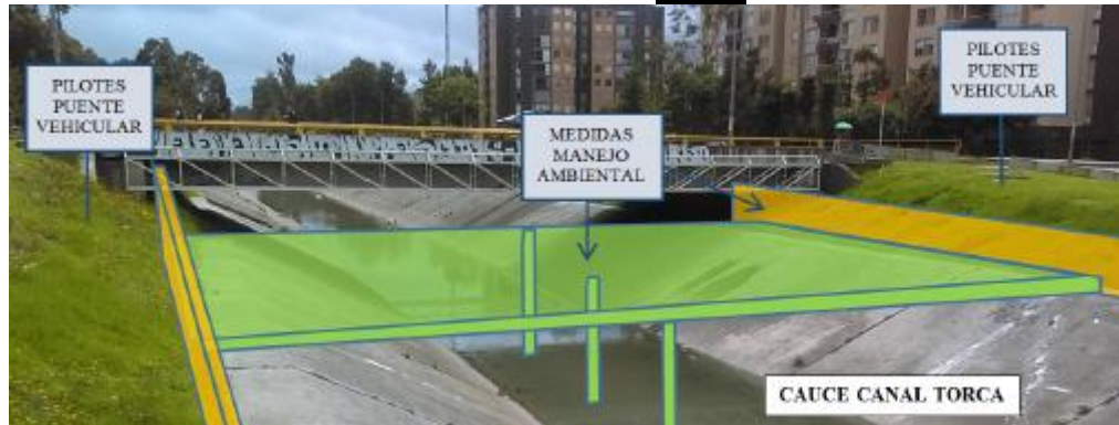
Fotografía No. 3. Zona de ubicación de las medidas de manejo ambiental a implementar para la construcción de puente vehicular sobre el canal Torca.
